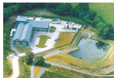
Пример труднодоступной насосной станции
